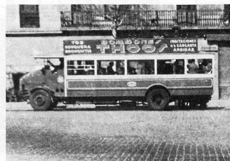
Fotografía posterior a las dos anteriores, donde se ponen de manifiesto algunas importantes diferencias: plataforma delantera (delatada por las dos barras blancas tras la ventana) y frontal modificado, adoptando un tipo NAVAL de la tercera serie, retrasando la cabina respecto al motor. Coche 16.
